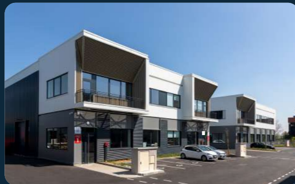
Parc Spirit de Chassieu • Chassieu (69) Grand Lyon la Métropole - ORY Architecture
