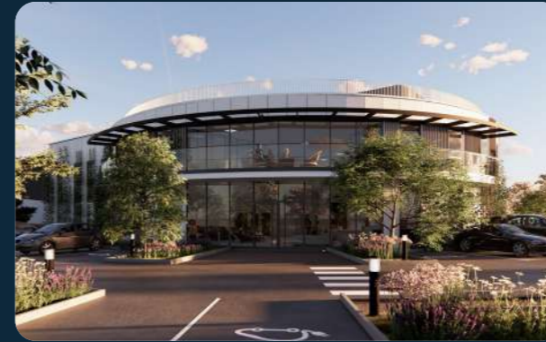
Clé en main Green Power Technologie • Étrelles (35) MN Architecture
